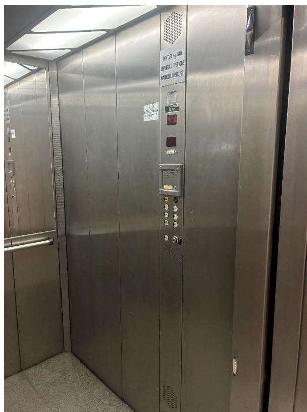
Ascensore n.2 (Sala Caldaie)
