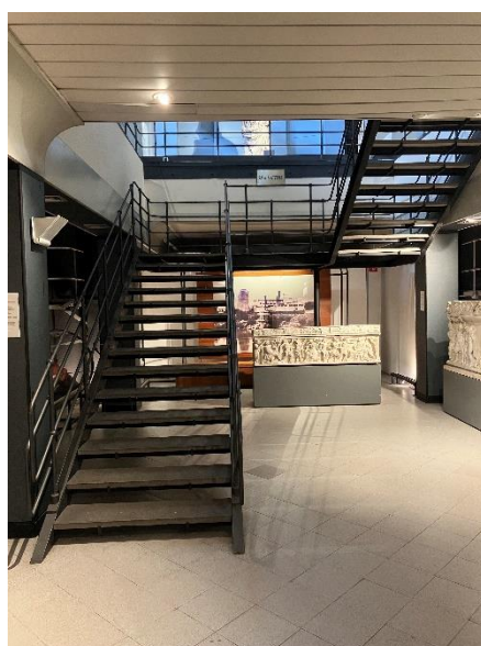
Scala di collegamento tra il Livello 0 (Sala Colonne) e il Livello 1 (Sala Macchine)
